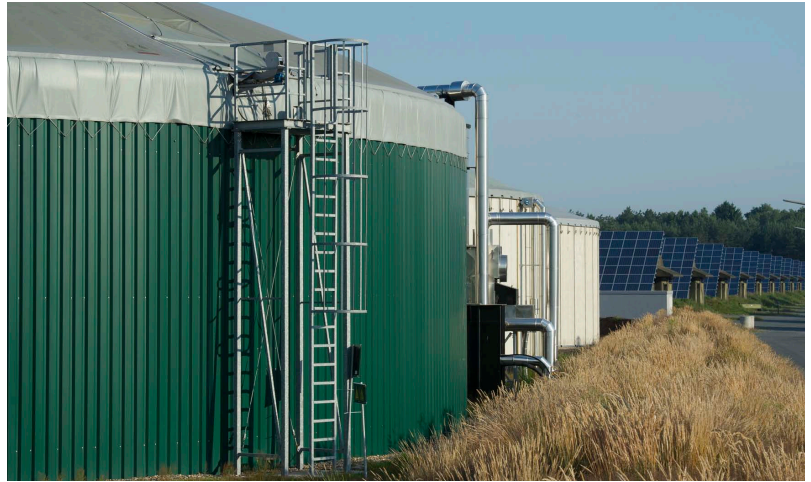
Ein Envitec-Projekt: Die Anlage der Saergas im BEP.
